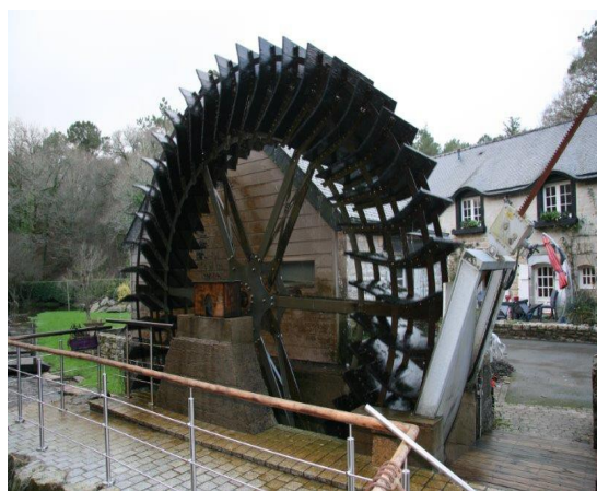
Un ancien moulin équipé pour produire de l'électricité
