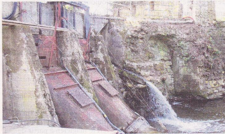
Les deux turbines en état de marche prennent place juste à côté des pierres multiséculaires de l'ancien moulin fortifié.
